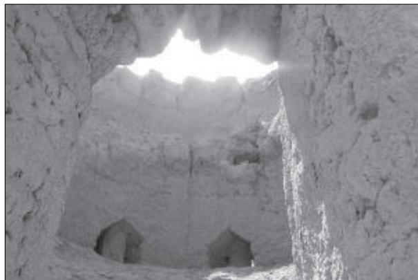
تصویر ۲۳. یکی از برج‌های قلعه رستم که در آن تیرکش‌های مثلثی مشخص هستند (عکس از: سلطانی).
