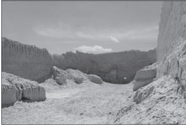
تصویر ۱۷. فضای تخریب‌شده در ضلع غربی قلعه رستم (عکس از: سلطانی).
