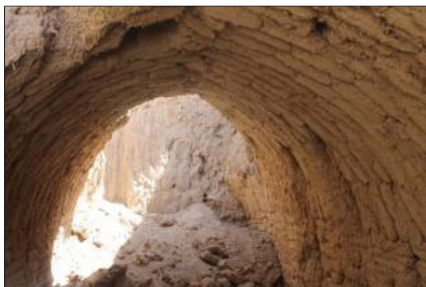
تصویر ۱۴. نحوه چیدمان پوشش فضای احتمالی آذوقه (عکس از: سلطانی، ۱۳۹۴).
