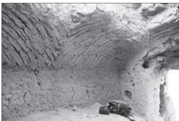
تصویر ۱۲. نحوه چیدمان فیل پوش فضای ورودی قلعه رستم (عکس از: سلطانی، ۱۳۹۴).
